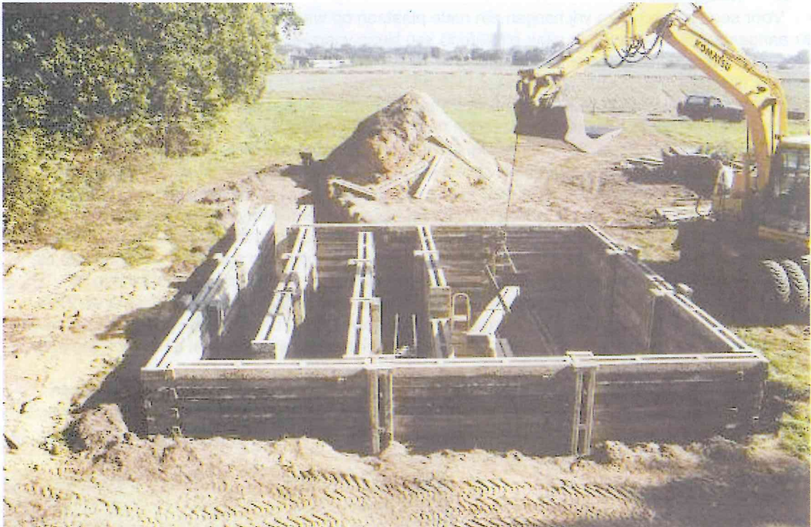
Een kelder in aanbouw. De vloer ligt onder het maaiveld, voor de stabiliteit en vochtigheid. Door de zigzag indeling ontstaat een lange gang. Foto: Roel Winters.
